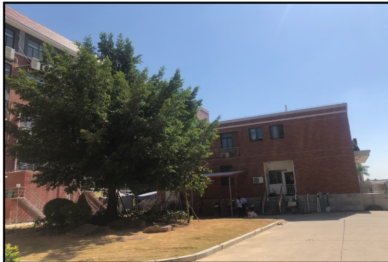
东北侧 园区物业服务中心及园区污水处理站
